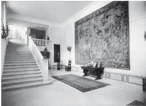
Vom Hafen kommend, betrat man die Villa durch ein repräsentatives Treppenhaus.
