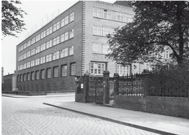
Das Einkaufshaus an der Dresdner Straße in Chemnitz
