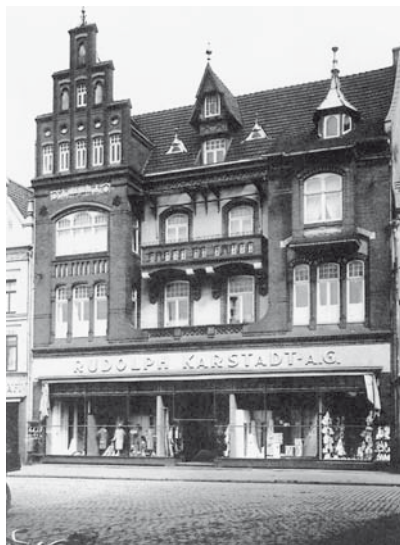
Rudolph Karstadt Warenhaus, ehemals M. J. Emden Söhne, Lüneburg am Markt
